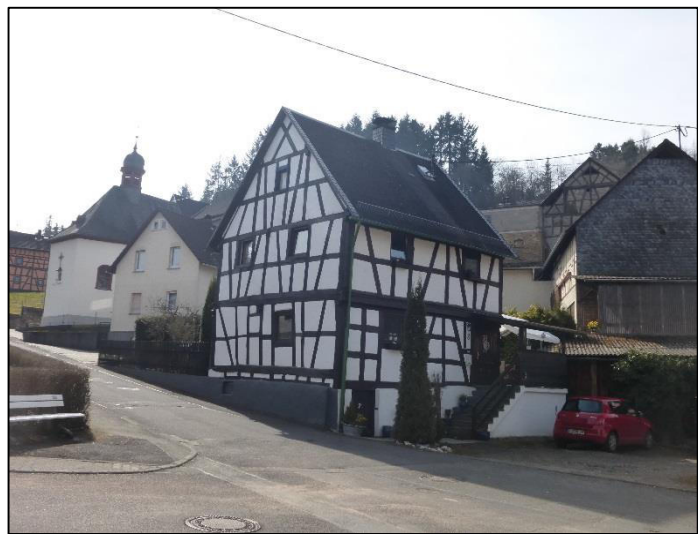
Fachwerkgebäude in der Nikolausstraße, im Hintergrund die Kapelle St. Nikolaus
