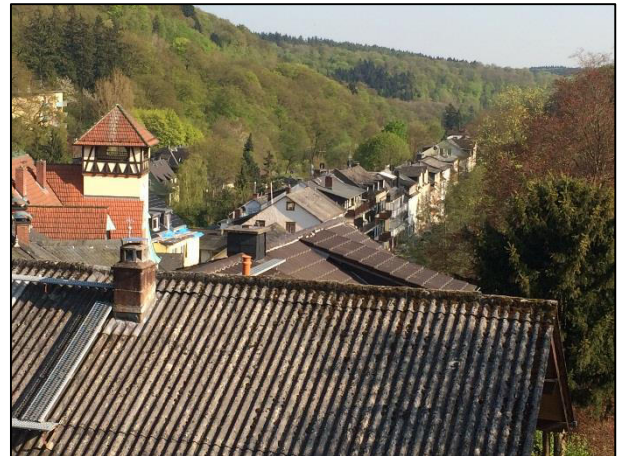
Ansicht Mühlstraße Blickrichtung Südosten
