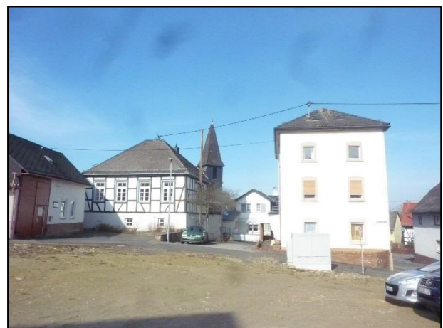
Als Parkplatz genutzte Brachfläche in der Ortsmitte
