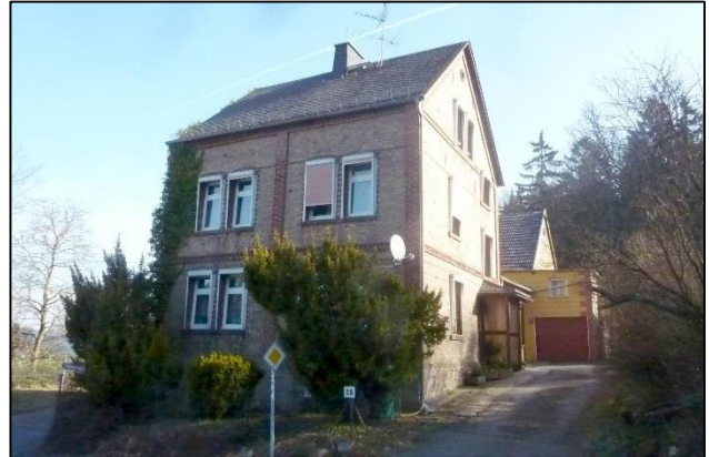
Gründerzeitlicher Ziegelbau in der Rüdesheimer Straße
