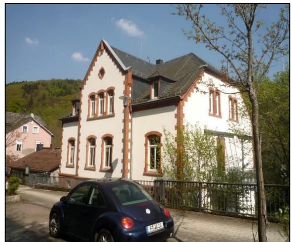
Schlangenbad: Symmetrische Fensteranordnung bei einem Gründerzeit-Gebäude
