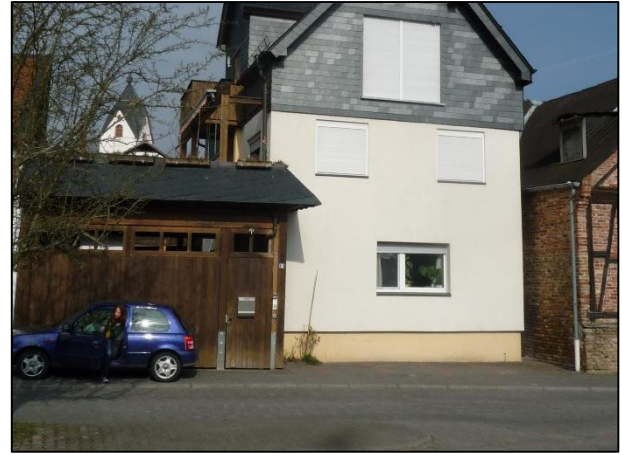
Bärstadt: Torhaus als Element des Straßenraumes
