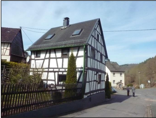
Obergladbach: Einfriedung mit ortstypischem Holzzaun
