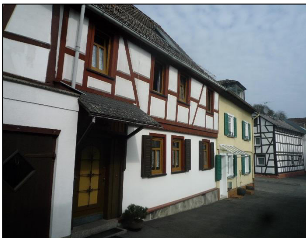
Hofreitenstruktur abgehend von der Hauptstraße
