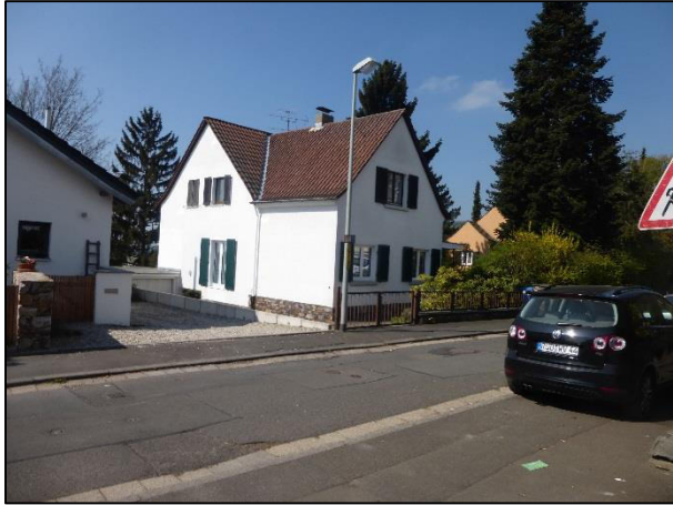
Georgenborn: steiles Satteldach eines typischen Gebäudes der 1950er Jahre
