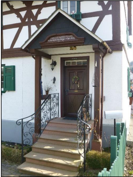
Niedergladbach: Hauseingang mit Vordach, Treppe aus rotem Sandstein und schmiedeeisernem Geländer
