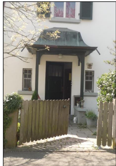
Georgenborn: Eingang und Vordach aus der Zeit zwischen den Weltkriegen (Heimatstilarchitektur)
