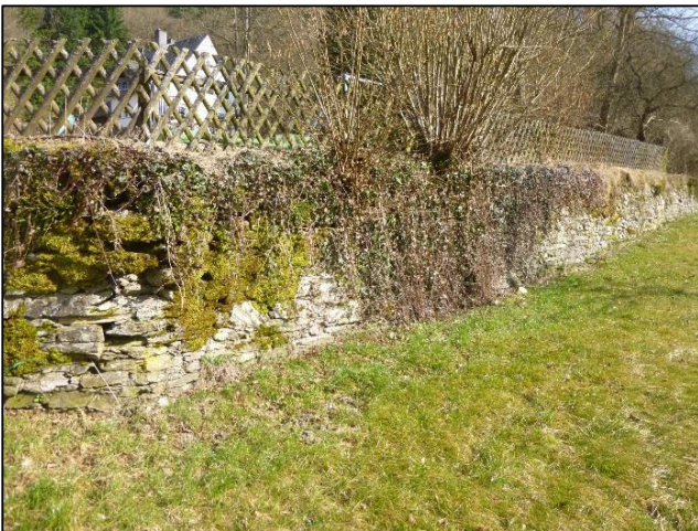
Niedergladbach: Stützmauer aus Natursteinen
