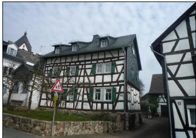
Bärstadt: verputzte Gefache und Sockel aus Natursteinen
