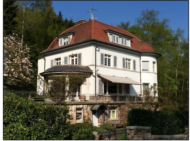
Schlangenbad; Besondere Dachform: Geschwungenes Mansarddach mit Schleppgaube
