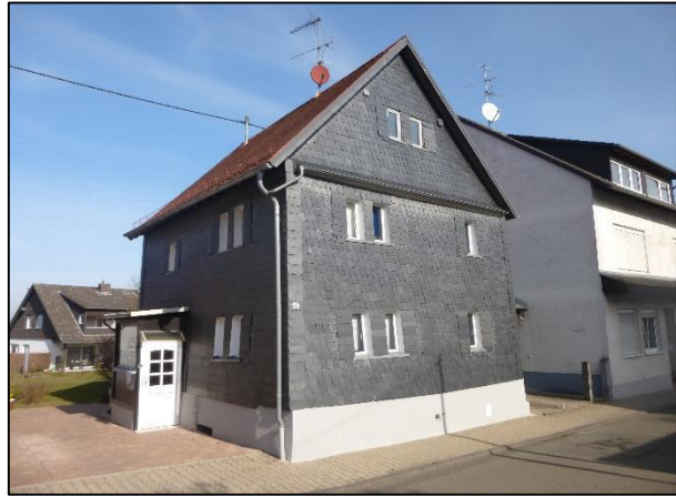
Hausen: Gebäude mit Schieferbehang
